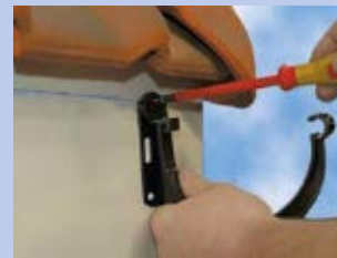
1-2 - Nostipriniet teknes āķus, ņemot vērā kritumu 3 mm uz 1 tekošo metru
